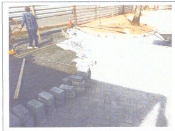
Assentamento de intertravado
